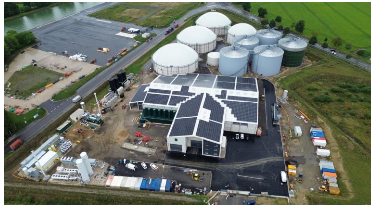
Foto von der Biomethanganlage in Bohmte (Juli 2025)
