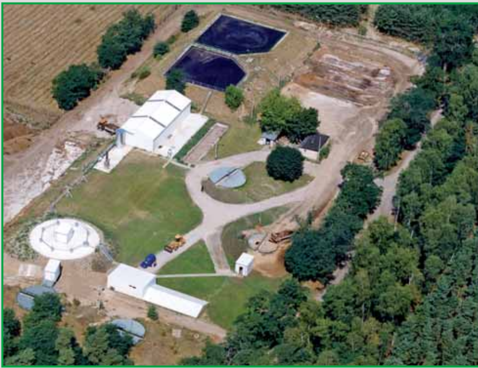
WIESENHOF-Biogasanlage in Möckern in der Bauphase 2003.
